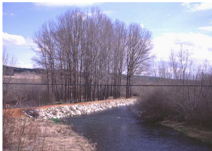
Figura 3. Modificación de la sección con por una escollera.
